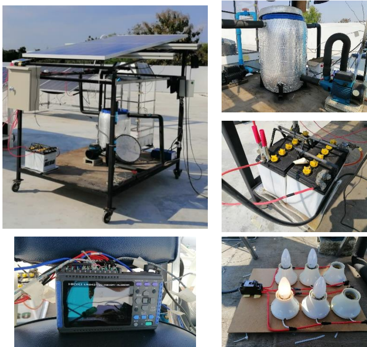
รูปที่ 5 อุปกรณ์และเครื่องมือที่ใช้ในการทดสอบประสิทธิภาพของแผงเซลล์แสงอาทิตย์ที่มีการติดตั้งที่ระบายความร้อน
