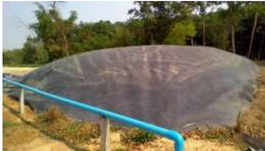
รูปที่ 2 บ่อหมักก๊าซชีวภาพแบบ Cover Lagoon
