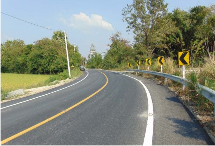
รูปที่ 5 สภาพถนนหลังการซ่อมบำรุง
