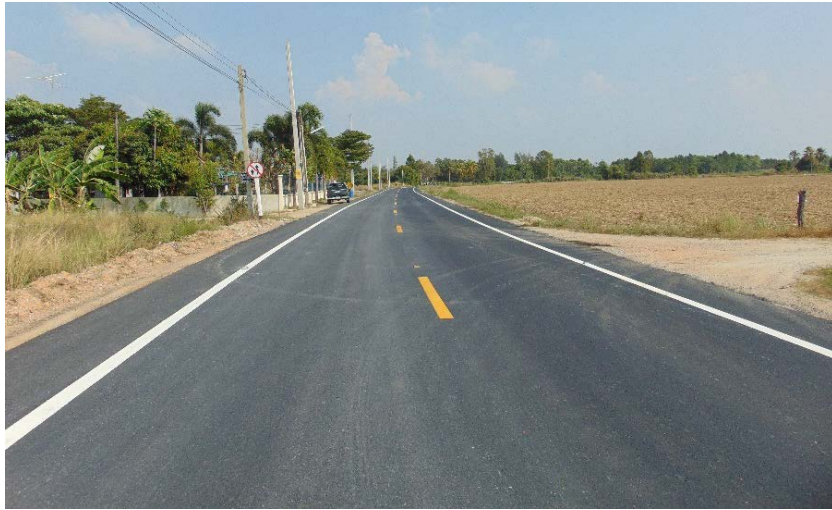
รูปที่ 3 สภาพถนนหลังการซ่อมบำรุง
