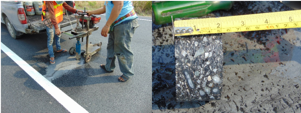
รูปที่ 6 ทดสอบการเจาะคอนกรีต
