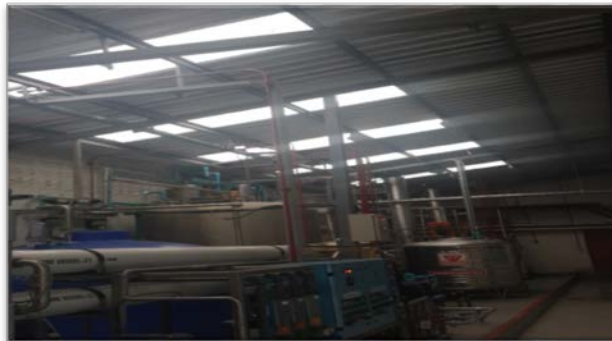
รูปที่ 4 การติดตั้งแผ่นไฟเบอร์โปร่งแสงบริเวณหลังคา
