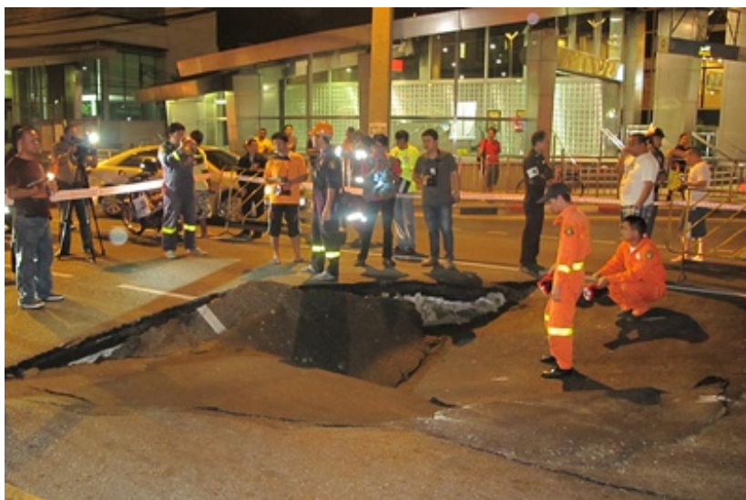
รูปที่ 2 ถนนและทางเท้าที่มีความเสี่ยงยุบตัว [4]
