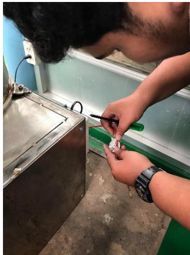
รูปที่ 9 ประกอบชุดสายไฟเข้ากับกล่องควบคุมความเร็วรอบมอเตอร์
