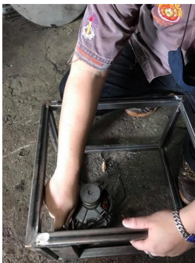
รูปที่ 5 การติดตั้งมอเตอร์
