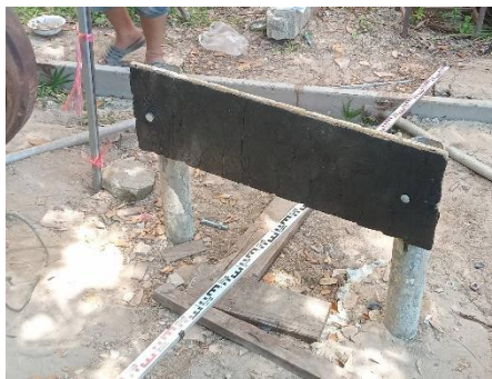
(ค) การติดตั้งราวกันอันตรายชนิด ABS+PS
