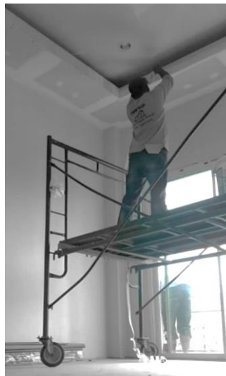
รูปที่ 4 มาตรการความปลอดภัยในการทำงานติดตั้งฝ้าเพดาน
