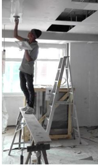
รูปที่ 3 สภาพแวดล้อมในการทำงานก่อนนำมาตรการความปลอดภัยมาใช้
