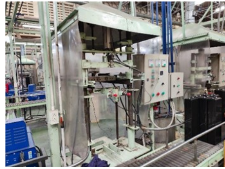
ภาพที่ 10 สถานที่งาน HEATSEAL BATTERY โพลีคลิฟท์
