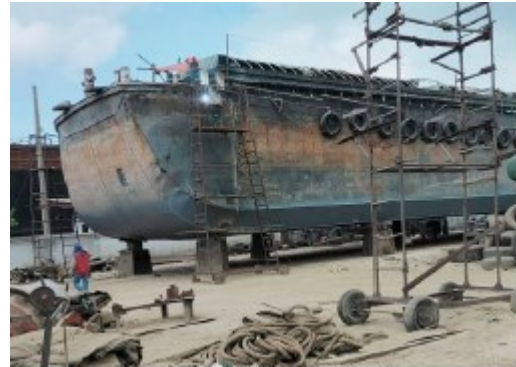
ภาพที่ 1 สภาพโรงงานต่อเรือบรรทุกขนาดกลาง
