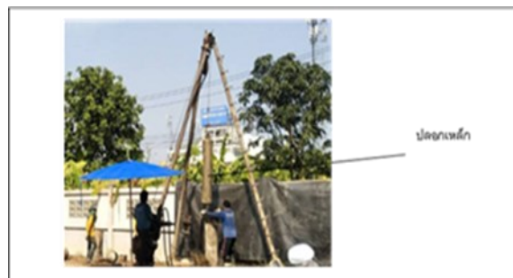
ภาพที่ 2.1 ย้ายชุดชุดเจาะเข้าสู่ตำแหน่งศูนย์กลางเสาเข็ม
