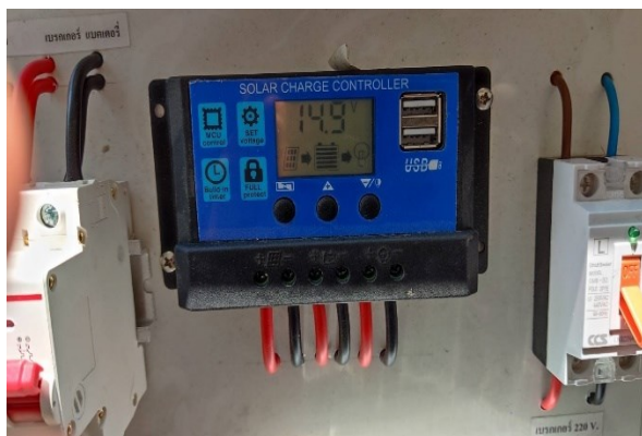
รูปที่ 18 กระแสและแรงดันของการเก็บประจุแบตเตอรี่จากดีซีชาร์จเจอร์
