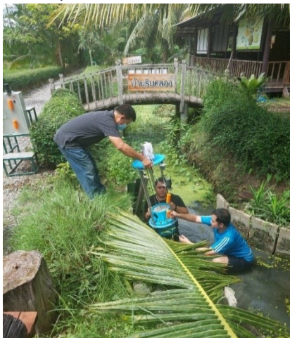
ภาพที่ 17 นำตัวเครื่องไปติดตั้งเข้ากับท่อพีวีซี ขนาด 8 นิ้ว
