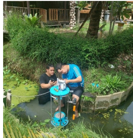
ภาพที่ 18 ทำการติดตั้งสายไฟ
