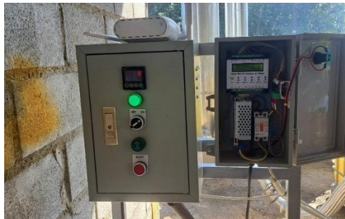
รูปที่ 11 ชุดระบบระบบอินเทอร์เน็ตออฟติงส์
