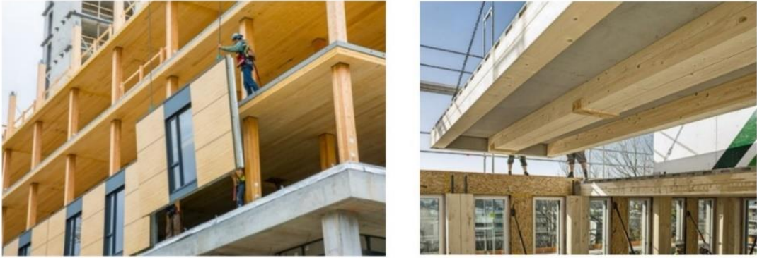
รูปที่ 2 ชั้นส่วนสำเร็จรูปประกอบอาคารที่ทำด้วยไม้ประกอบ [3]
